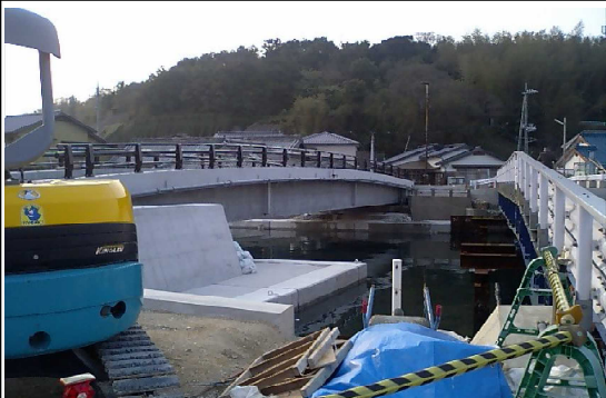
新しい平和橋（左）仮橋（右）手前が新川向こうが鶴江 26日
